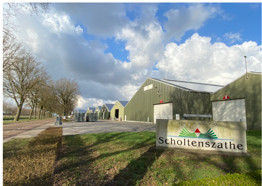
Duizenden zonnepanelen op de daken van de opslagruimtes van Landgoed Scholtenszathe in Klazienaveen-Noord. Foto: Werkbureau Res-regio Drenthe
