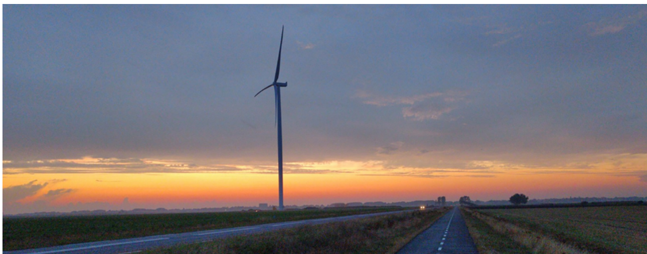
Eerste gebouwde windturbine van het windpark DEE in Borger-Odoorn
