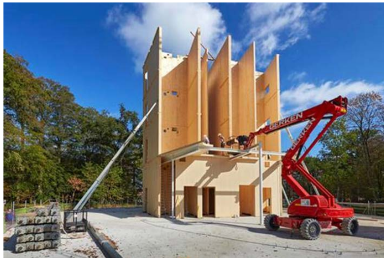
Figuur 2: CLT-kern van de Triodos Bank in Driebergen (JP v Eesteren)
