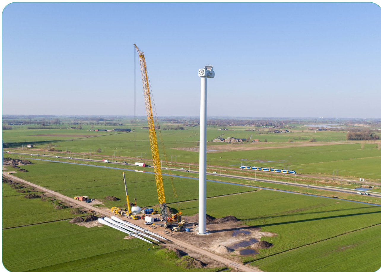
Aanbouw van vier windmolens langs N50 (nabij knooppunt Hattermerbroek) – april 2021
