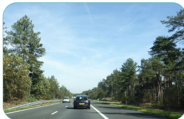
A28 als energieroute onderzocht.
