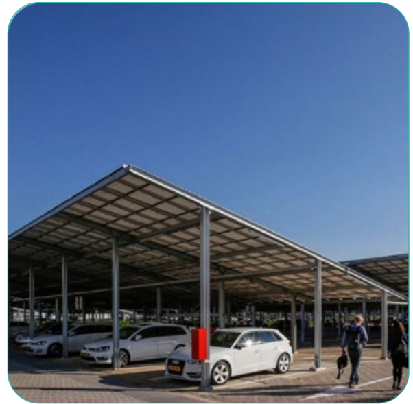
Parkeerterrein op defensie terrein, overkapt met zonnepanelen.
