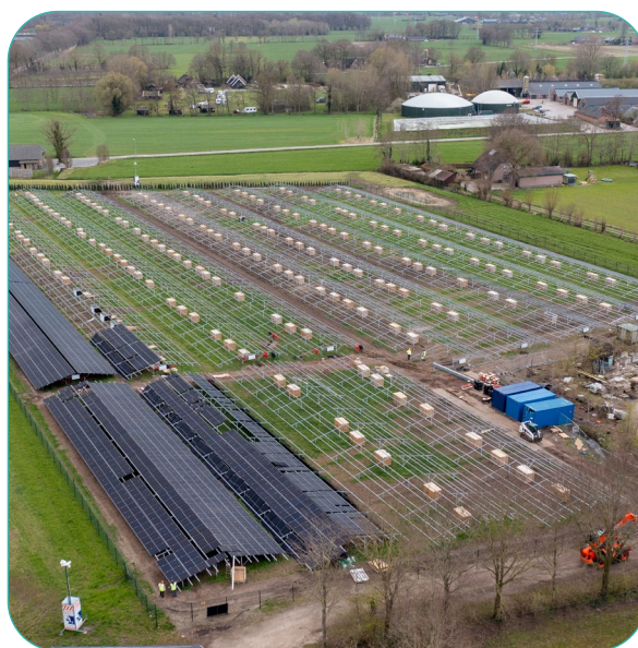
Aanbouw zonnepanelenveld bij Aalbertshoeve in Ermelo - april 2021
