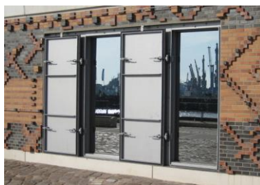
Waterdichte deuren Hamburg HafenCity. Foto: Defacto stedenbouw.
