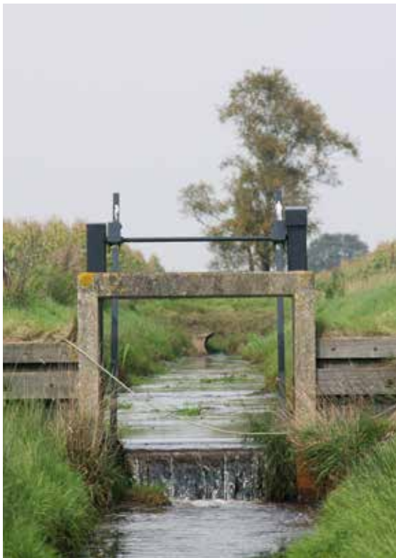
Figuur 2 Stuw om water vast te houden.
